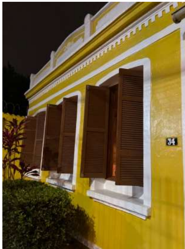
Foto da fachada do Teatro do Kaos após a reforma.
