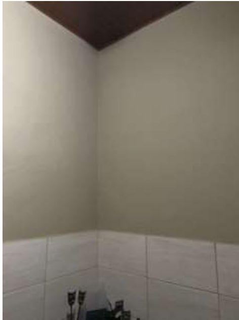
Foto da sede do Teatro do Kaos, após a reforma.
