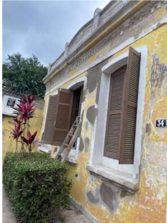
Foto da fachada do Teatro do Kaos antes/durante a reforma.
